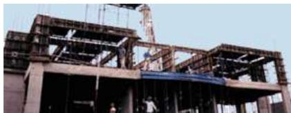
Estrutura reticulada de concreto armado
