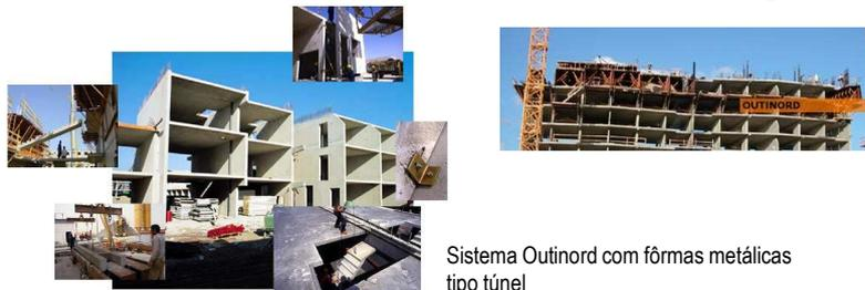
Sistema Outinord com fôrmas metálicas tipo túnel
