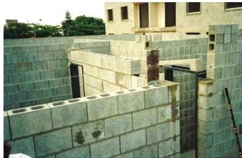
Processo construtivo de alvenaria estrutural de blocos de concreto
